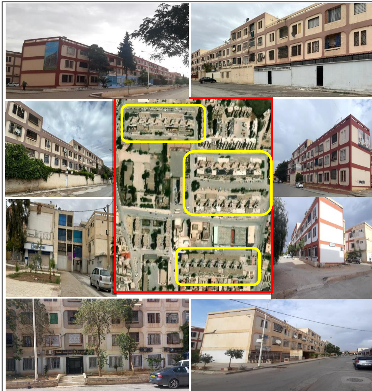
Figure IV.32 : Les blocs de la cité 742 logements. Source : Auteur, 2022.
