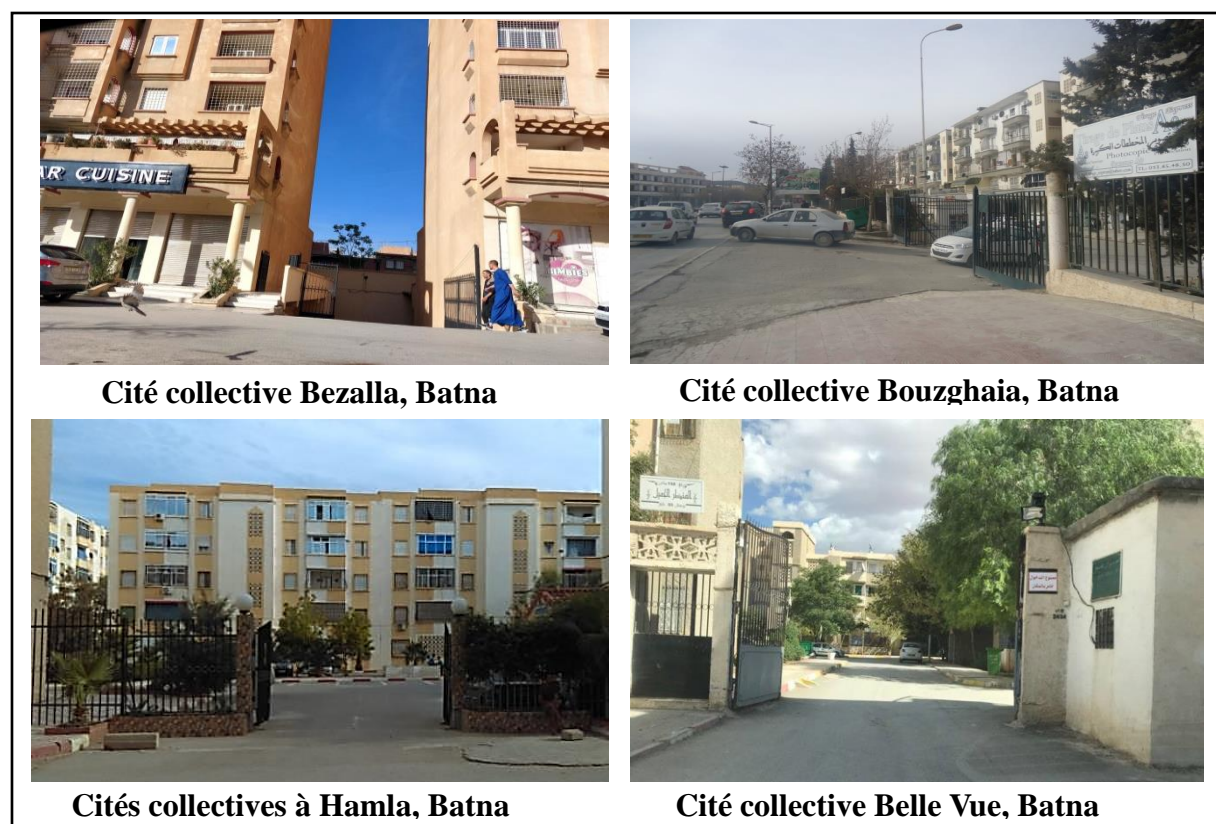
Figure IV.15 : Exemples des habitats collectifs conçus initialement comme cités fermées ou bien la clôture a été construite par les habitants de la cité. Source : Auteur, 2020.
