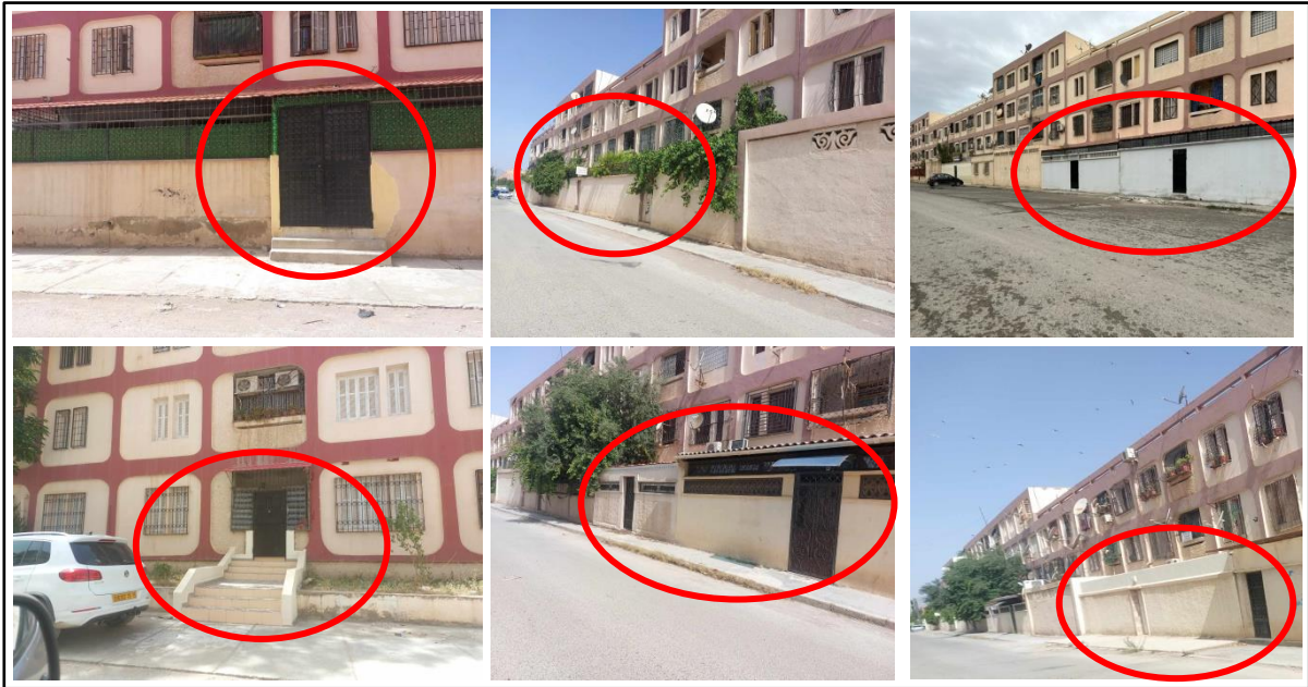
Figure V.16 : La création des accès privés au niveau du rez-de-chaussée par les usagers de la cité 742 logements. Source : Auteur, 2022.
