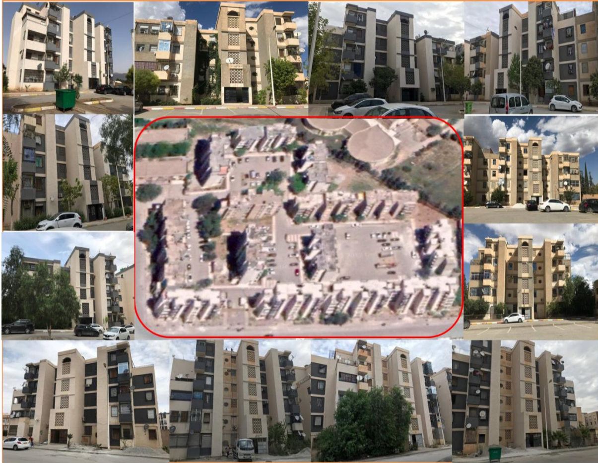
Figure IV.26: La distribution des blocs dans la cité des 150 logements. Source : Auteur, 2021.
