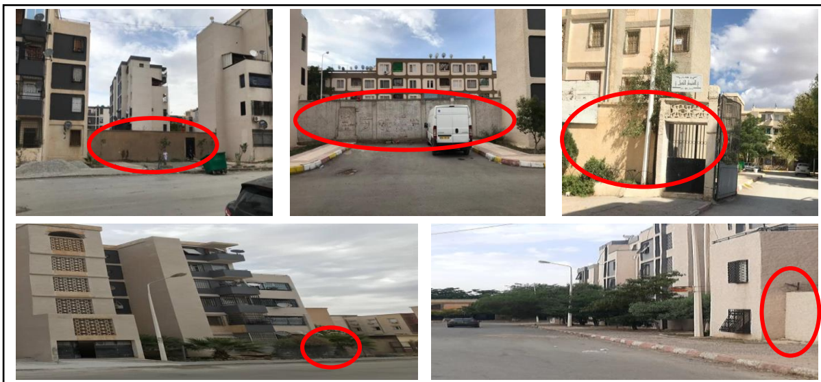
Figure V.6 : L'addition des murs de clôture sur les poches vides entre les bâtiments de la cité par les habitants. Source : Auteur, 2021.
